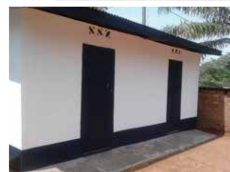
▲ Vue de blocs de quatre (04) latrines construit
