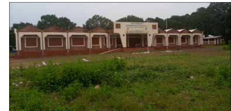
Building administratif de Paoua réhabilité par la MINUSCA
