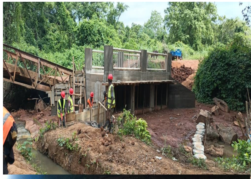
Image 11: Projet de construction du pont Gbawi (Kaga Bandoro FO)
