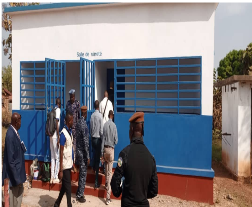
Projet de réhabilitation du commissariat de Bossangoa et des salles de sureté
