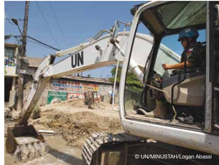
Un contingent de génie militaire prépare un terrain pour la construction d'une nouvelle route dans le quartier de Martissant à Port-au-Prince.
